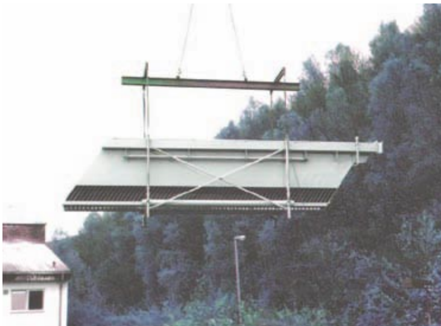
Figure 2 : Installation de lamelles en cours d'exploitation
